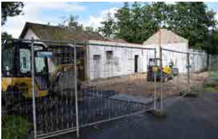
Abrissarbeiten am Feuerwehrrätehaus in Keelbek Foto: M.Montag
